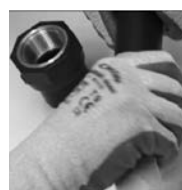
PRÉPARER LES SURFACES AVEC LE CLEANER+
