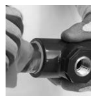
NETTOYER ET RESPECTER LE TEMPS DE SÉCHAGE
