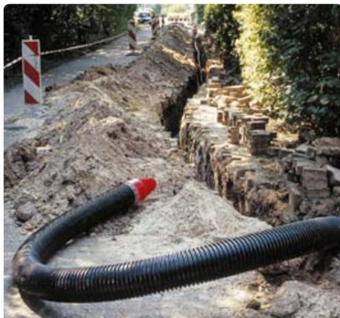
La flexibilité des canalisations Uponor leur permet de s'adapter sans problème à quasiment toutes les conditions de tracé sur site. Les conduites existantes peuvent être traversées par en dessus ou par en dessous, tandis que les obstacles peuvent être tout simplement contournés.
