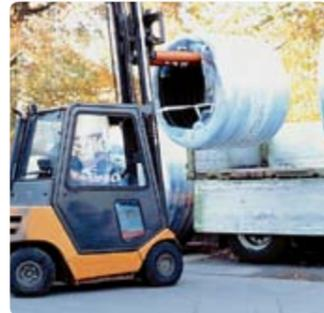
Les tubes du système pré-isolé Uponor sont livrés en couronnes sur le chantier, selon un procédé pratique et compact. En règle générale, le déchargement des couronnes s'effectue à l'aide d'une pelle mécanique de chantier ou d'autres dispositifs de levage. Lors du déchargement et pendant le stockage, le tube doit être protégé de toute détériorati-
