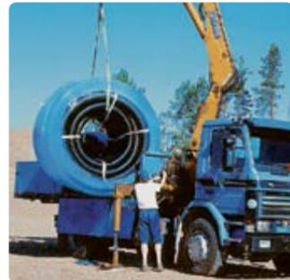
Les tubes du système pré-isolé Uponor doivent être stockés à l'horizontale. Le stockage doit s'effectuer sur un sol plan. Pour les protéger des rayons UV et des salissures. La conduite doit être protégée contre les pincements ou les distensions. Éviter fondamentalement tout contact des matériaux plastiques avec des substances ayant des effets préjudiciables telles que carburants pour moteur, solvants, produits
