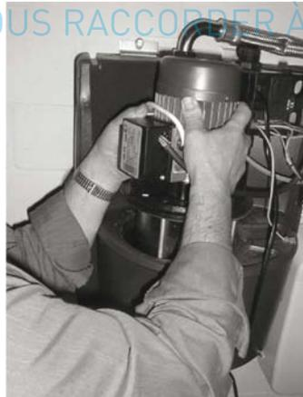
**8.4.2 Démontage de l'automate de commande de pompe**
