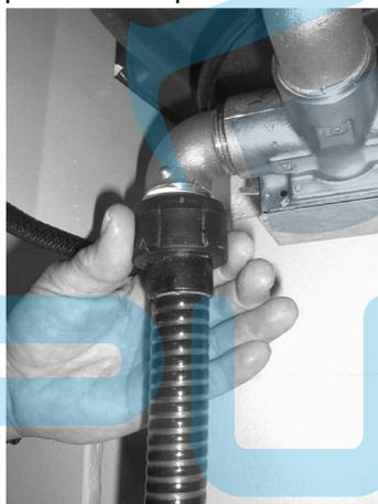
2. Monter un clapet anti-retour à l'extrémité de la conduite d'aspiration flexible ou rigide.
