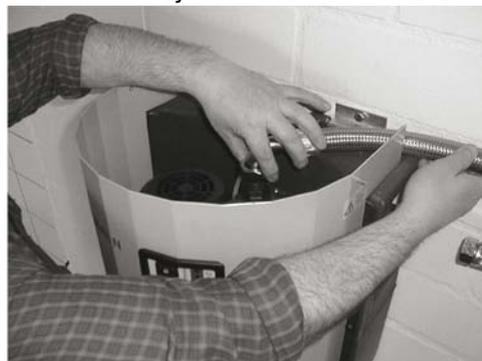
5. Remettre le capot en place et le fixer avec les écrous borgnes.
