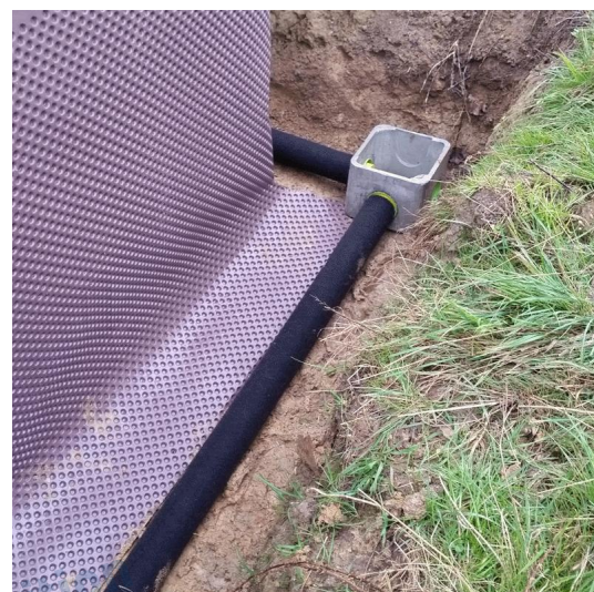
FIGURE N°18 : CHANGEMENT DE DIRECTION AVEC UNE BOITE D'INSPECTION
