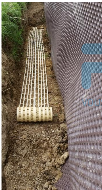
FIGURE N°27 : MISE EN ŒUVRE D'UN GRILLAGE AVERTISSEUR
