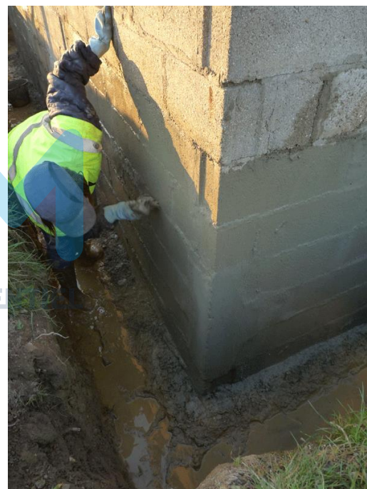
FIGURE N°11 : MISE EN ŒUVRE D'UN PRODUIT D'ETANCHEIFICATION
