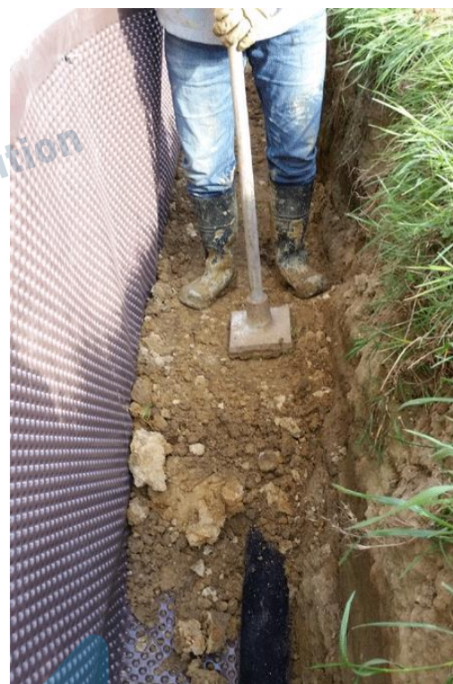
FIGURE N°26 : DAMMAGE MANUEL DES COUCHES DE REMBLAIS
