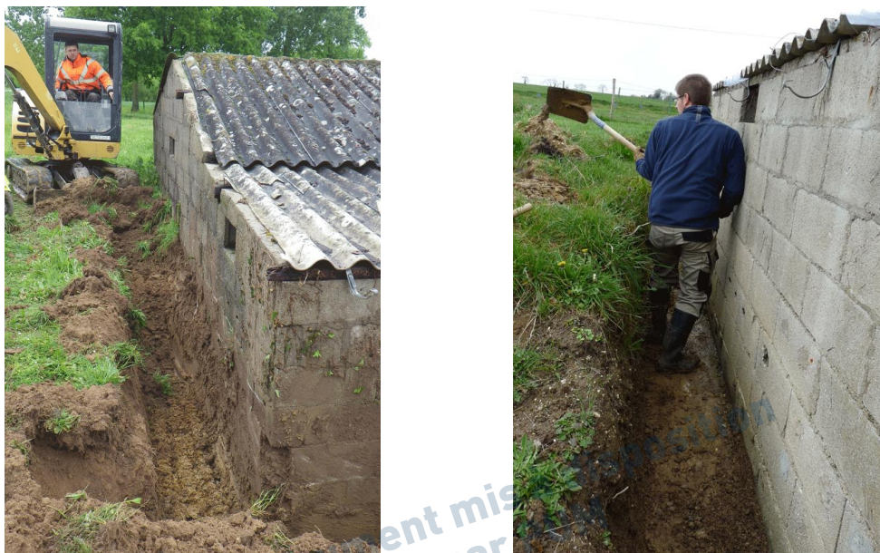
FIGURE N°3 : DEGAGEMENT DES FONDATIONS A L'AIDE D'UNE PELLE MECANIQUE ET FINITIONS A LA PELLE A MAIN
