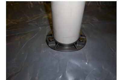
6. Passer le tuyau au travers
