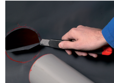
2. Tracer un cercle au marqueur autour du tuyau sur le film, puis découper le film.
