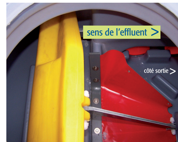
Position ouverte (Flotteur niveau haut, trappe ouverte)
